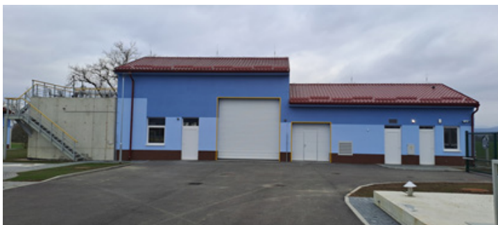
Novo vybudovaná ČOV Pruské – prevádzková budova
