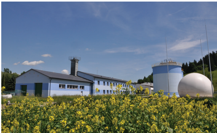
Existujúca čistiareň odpadových vôd v Dolnom Kubíne, na ktorej budú čistené odpadové vody od novopripojených obyvateľov obcí Žaškov a Párnica
