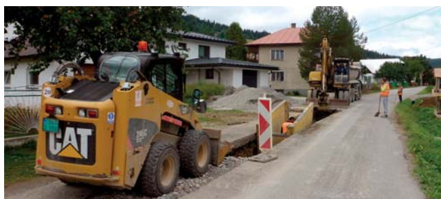
Budovanie gravitačnej kanalizácie v štátnej ceste III. tr. v obci Zákamenné.
