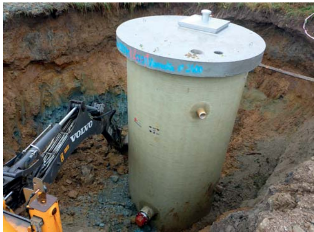
Osadenie čerpacej stanice odpadových vôd v obci Vavrečka. Uzatvorený čerpací systém STRATE v podzemnej sklolaminátovej prefabrikovanej nádrži.
